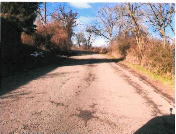
Hl. koroze, mozaikové trhliny, chybějící nezp. krajnice
