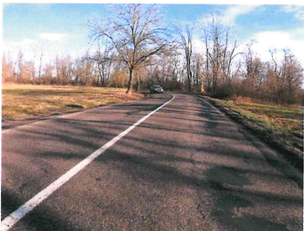
Hl. koroze, podélné/mozaikové trhliny, vysprávkky, hrboly
