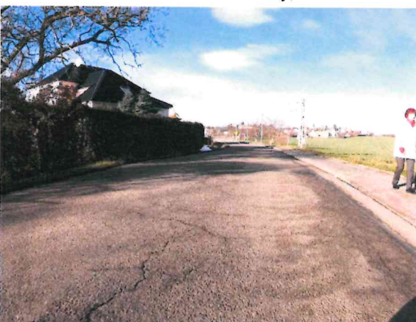
Hlubková koroze, podélné/mozaikové trhliny
