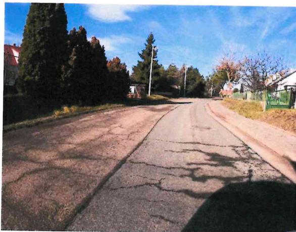
Hl. koroze, podélné a příčné trhliny, vysprávkky, hrboly
