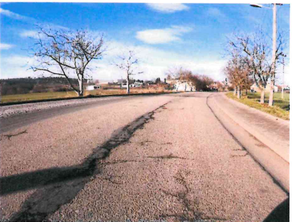
Hlubková koroze, podélné a mozaikové trhliny
