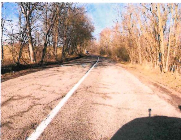
Hl. koroze, mozaikové až síťové trhliny, deformace
