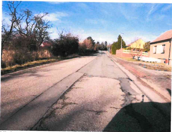
Hl. koroze, pod. a mozaikové trhliny , vysprávkky, hrboly
