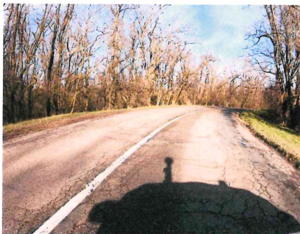
Hlubková koroze, síťové trhliny, plošná deformace
