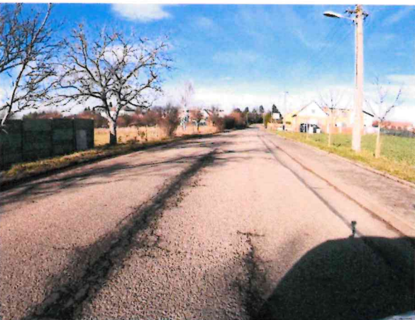
Hlubková koroze, podélné a mozaikové trhliny
